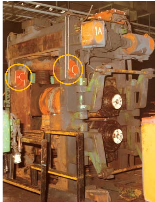
Typisk fyrsatsinstallation med två töjningsmätare på arbetssidan och två på drivsidan.
